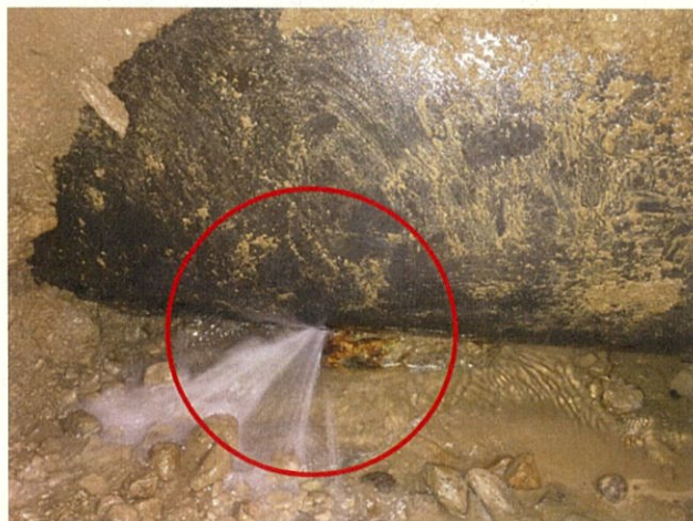
【 第 3 段階 貫通腐食 】 (管の腐食が進行し、管に穴が開いている状態) (下部損傷状況)
