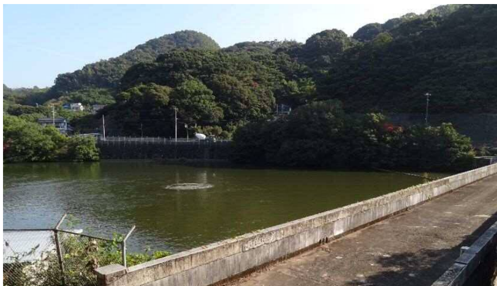
写真 浦上ダム曝気状況
