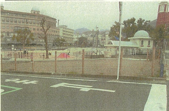
現況写真(解体後)
