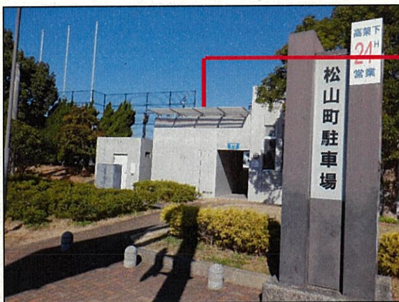
防水工（建物全景）
