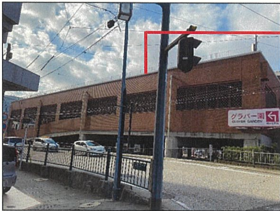
路面補修 (3階 (屋上部))
