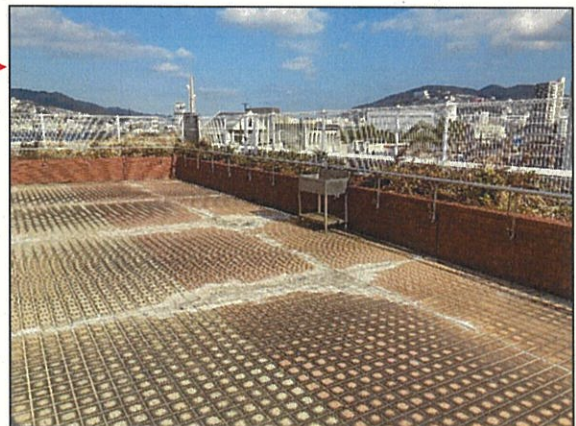
路面補修 (3階 (屋上部))
