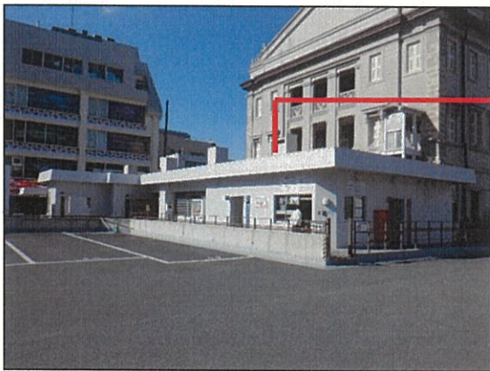
防水工（建物全景）
