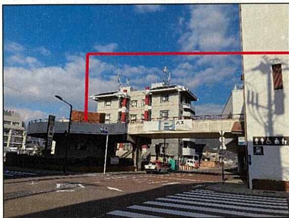
路面補修（2階（連絡通路））
