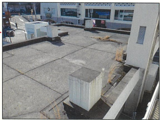
防水工（屋上部）
