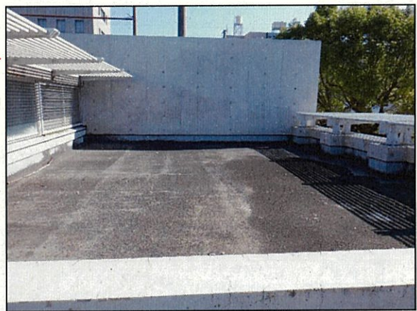
防水工（屋上部）
