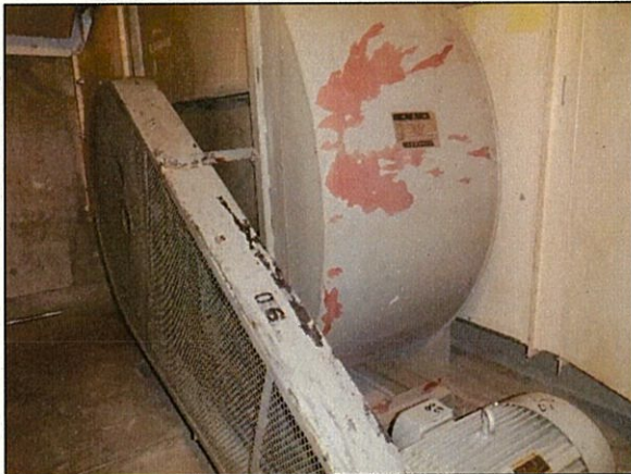
換気設備改修 (本体)
