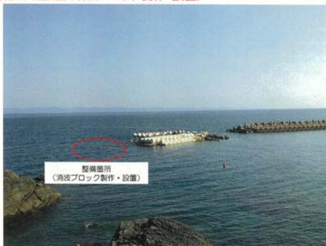
離岸堤設置箇所の現況
