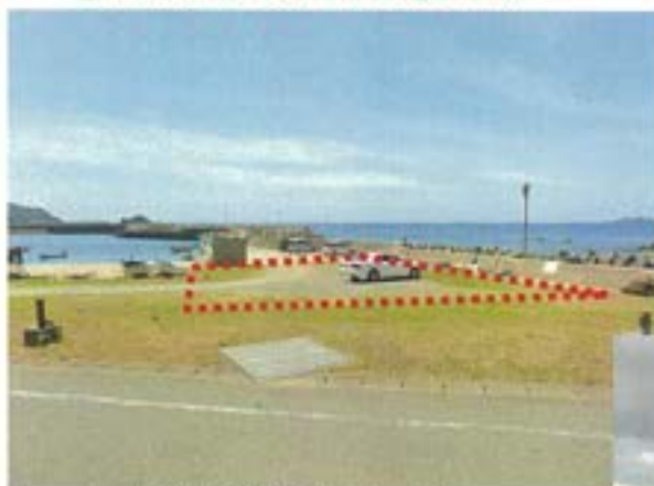
船揚場改良箇所の現況
