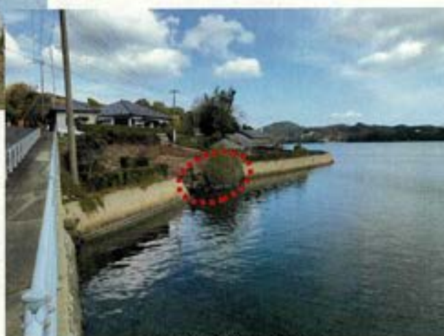
護岸改良箇所の現況
