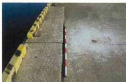
岸壁改良箇所の現況(空洞化による補修設計)
