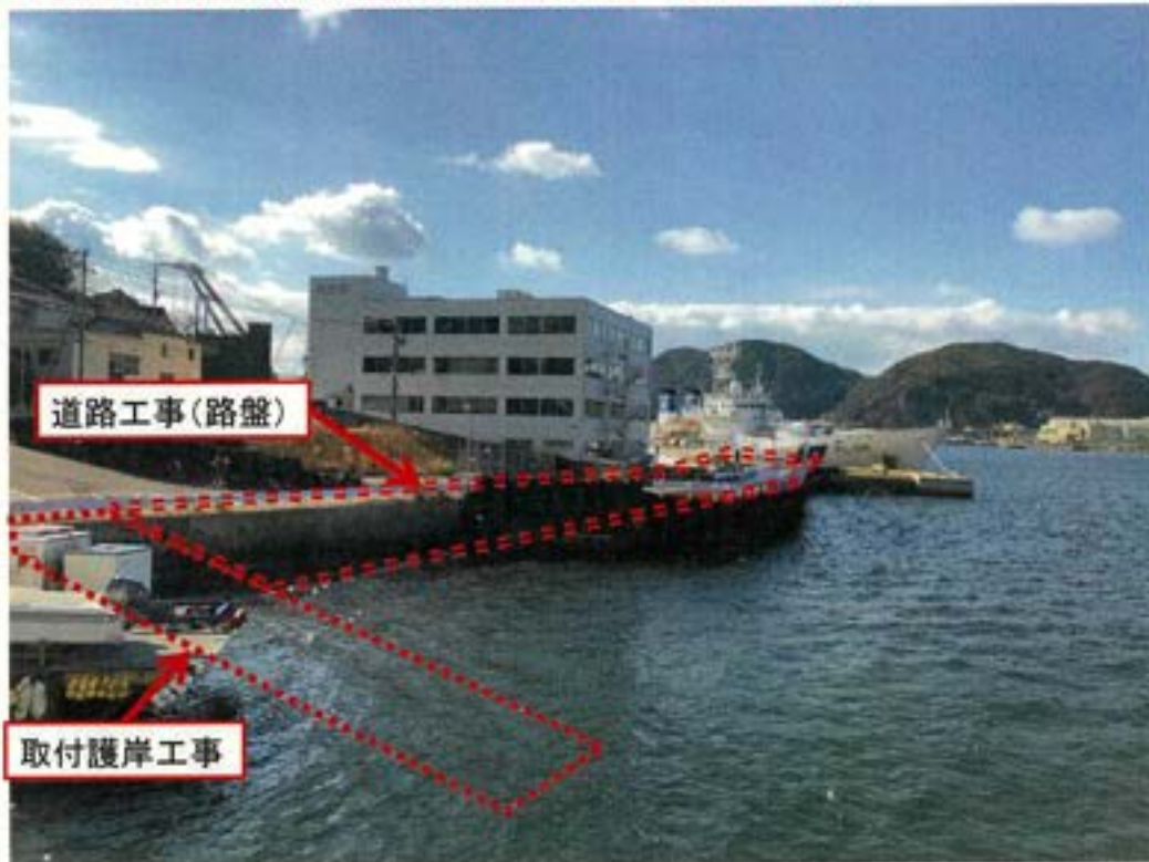
岸壁・道路改良箇所現況
