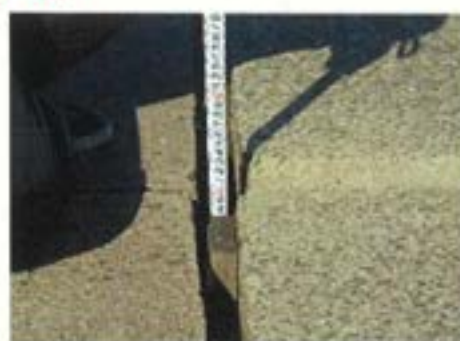
岸壁改良箇所の現況(空洞化による補修設計)
