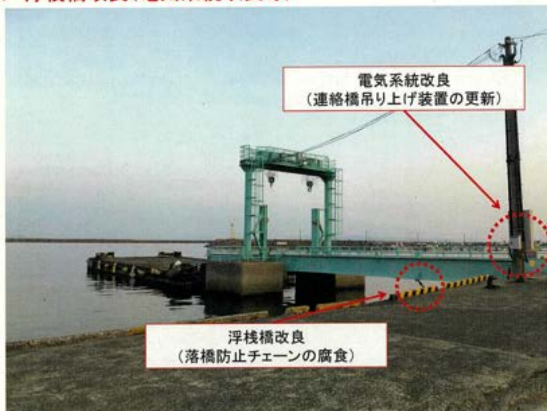
浮棧橋の現況
