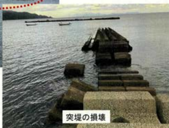
離岸堤・突堤改良箇所の現況
