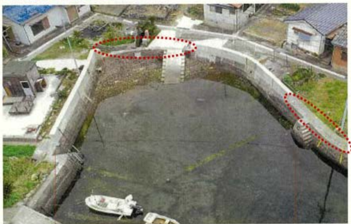
護岸改良箇所の現況(護岸の嵩上げ)
