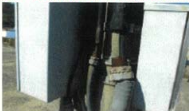
電気系統改良 (連絡橋吊り上げ装置の更新)
