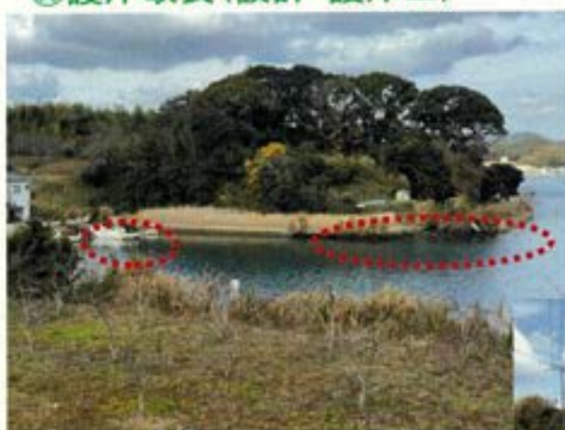
護岸改良箇所の現況
