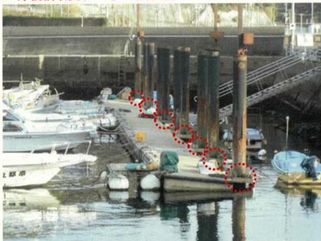
浮棧橋改良箇所の現況
