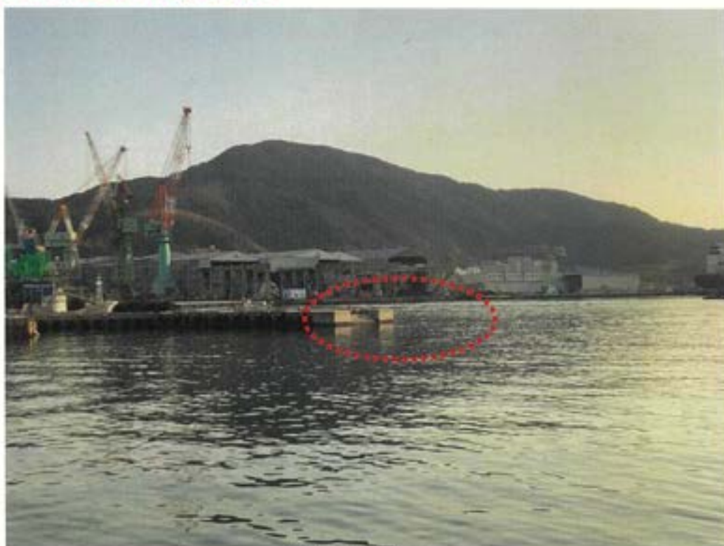
浮棧橋改良箇所の現況
