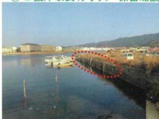
護岸改良箇所の現況
