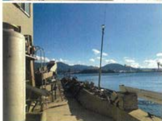
岸壁改良箇所の現況(照明灯支柱の変形・灯具の故障)
