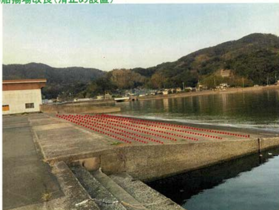
船揚場改良箇所の現況
