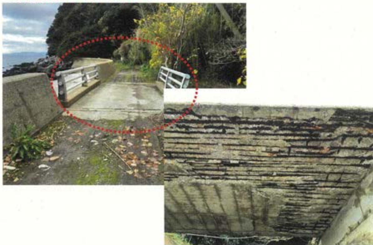
橋梁改良箇所の現況
