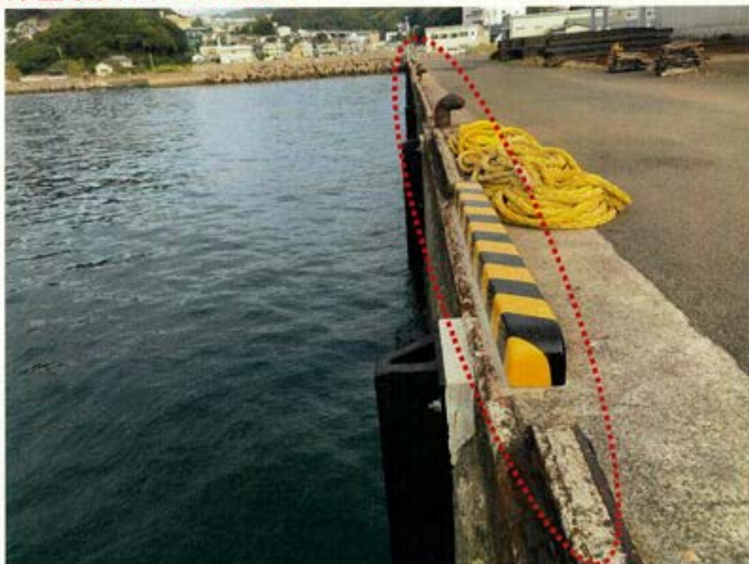
岸壁改良箇所の現況
