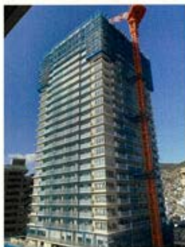
北街区（26階立上完了）
