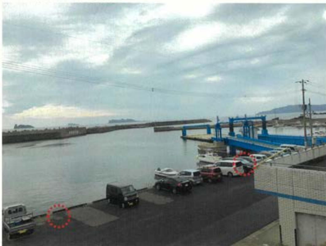
岸壁改良箇所の現況
