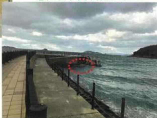
突堤改良箇所の現況
