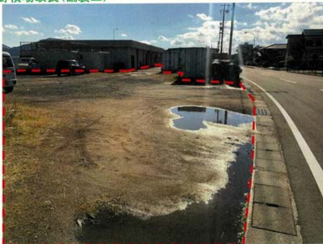
野積場改良箇所の現況
