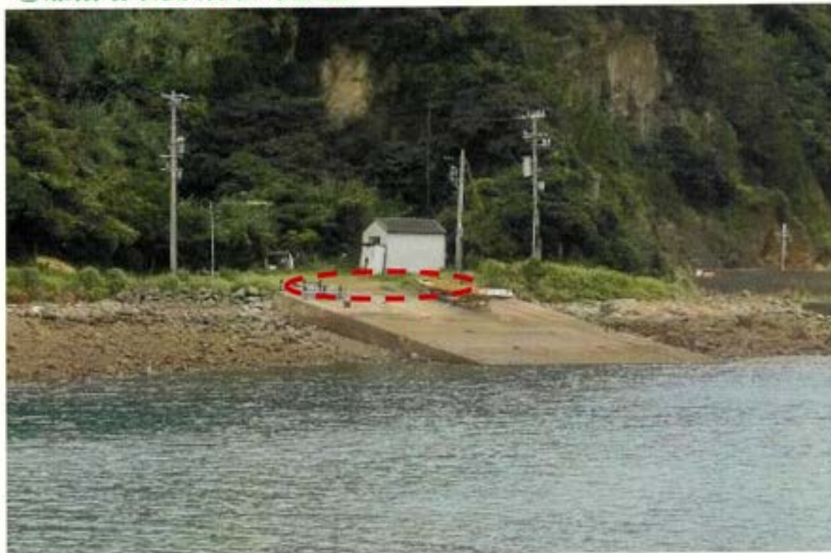
船揚場改良箇所の現況
