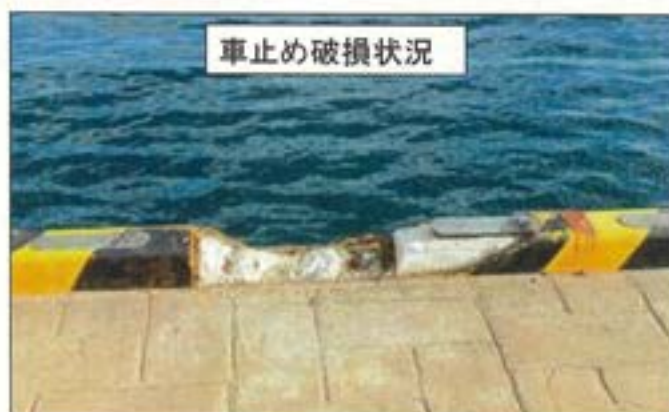
物揚場改良箇所の現況
