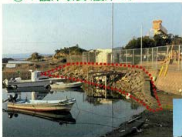
護岸改良箇所の現況
