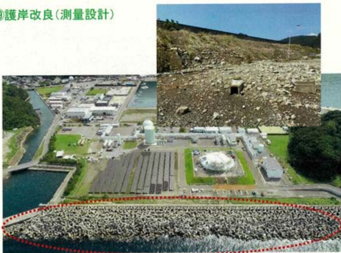
護岸改良箇所の現況(高潮・波浪による背後地のインフラ施設(ガス工場)等の被災)
