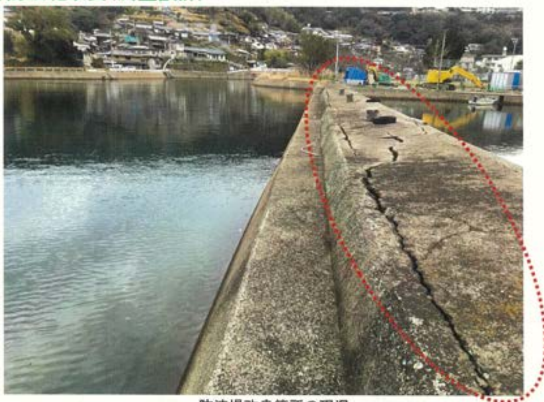
防波堤改良箇所の現況
