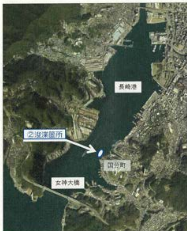
浚渫箇所(航空写真)
