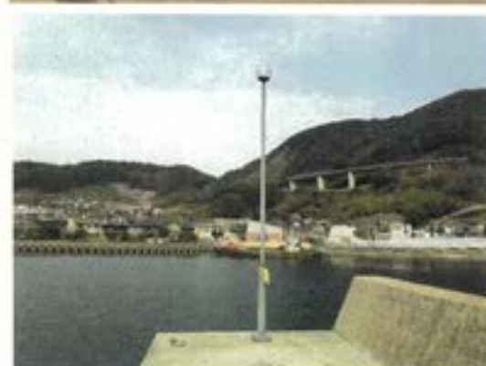
岸壁改良箇所の現況(照明灯支柱の変形・灯具の故障)
