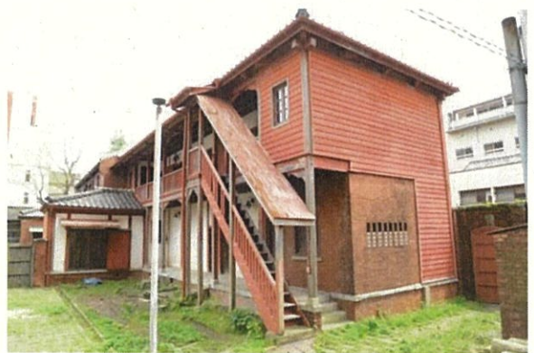
職員住宅（木造棟）
