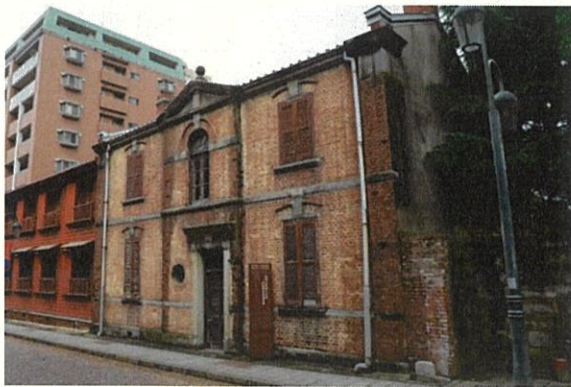
職員住宅（煉瓦棟）
