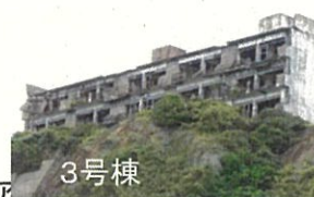
居住施設エリア 3号棟
