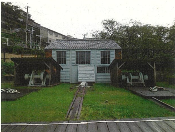
史跡内曳き揚げ機小屋 (正面)
