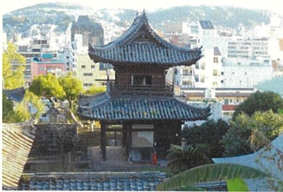
鐘楼 (北側面全景)
