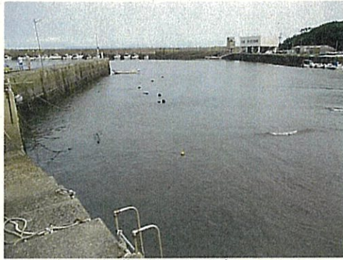
漁港内状況写真
