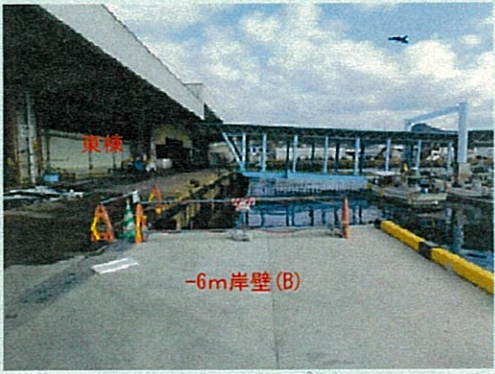
撮影：令和4年1月（-6m岸壁(B)）
