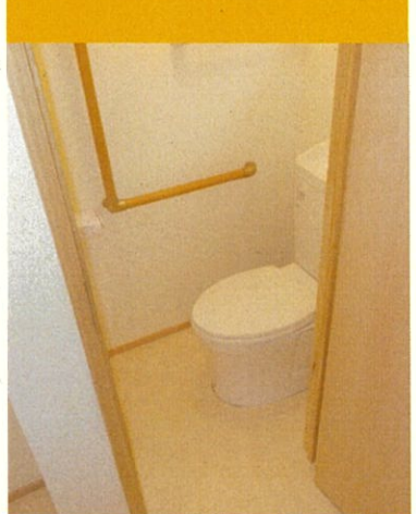
トイレ 手摺が付き、節水型の洋便器になります。
