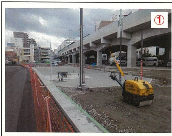
施工状況（令和3年11月撮影）
