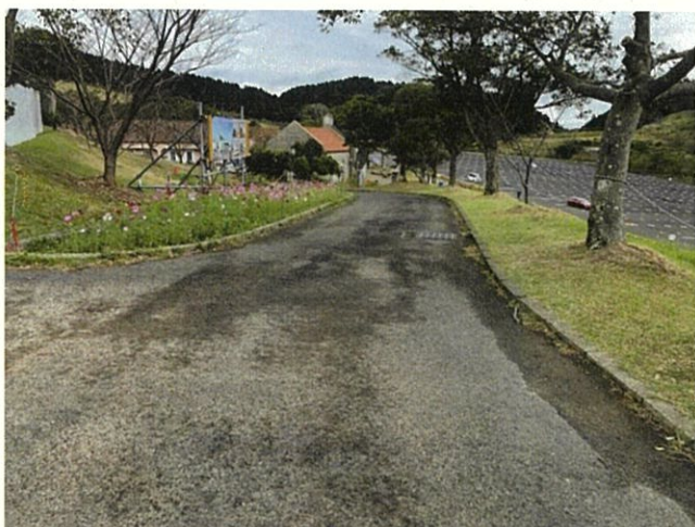
ア 通路に電気照明器具の設置
