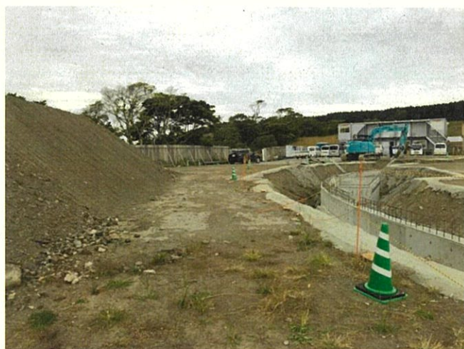
ウ アスファルト舗装
