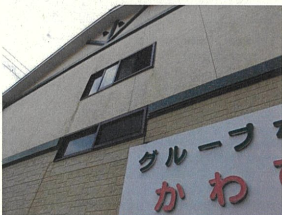
・バルコニー設置場所(屋外)
