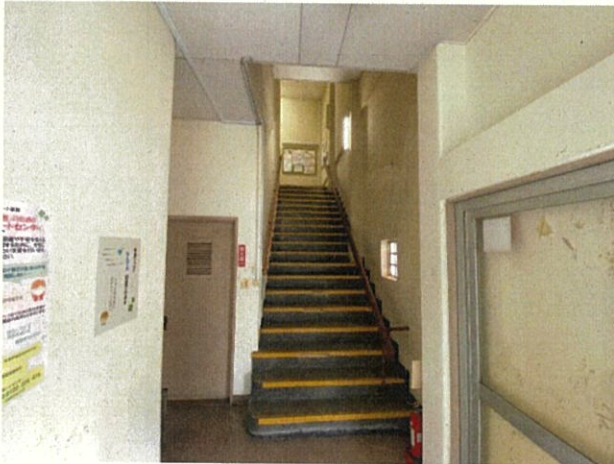
写真3 建物内階段（1階～2階）
