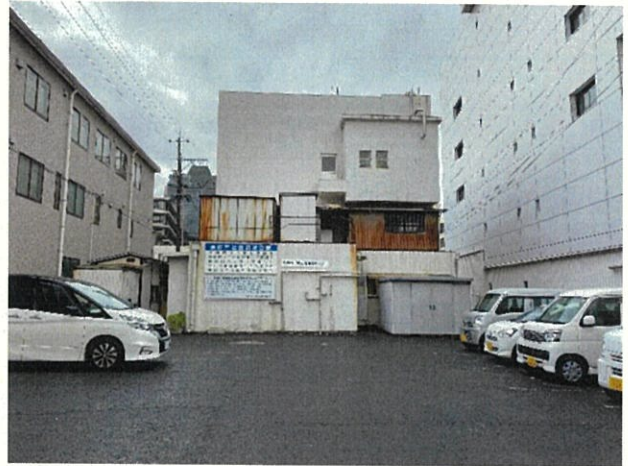
写真2 外観（裏通り側）
