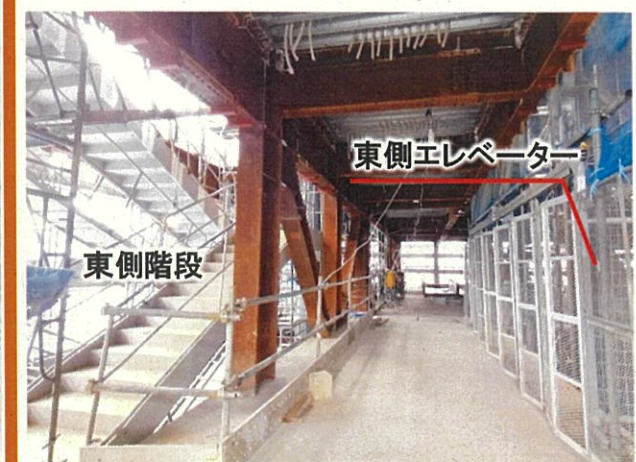
③ 東側エレベーターホール付近
