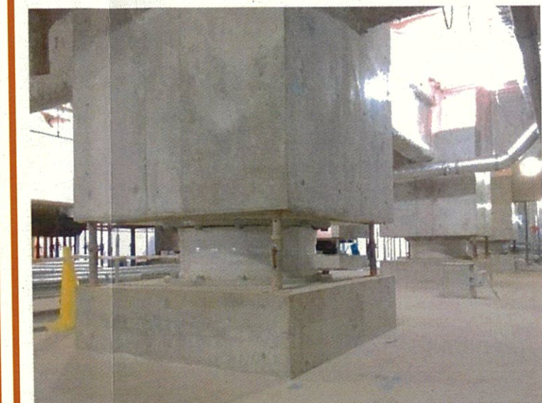
地下 建物内部(免震装置)
