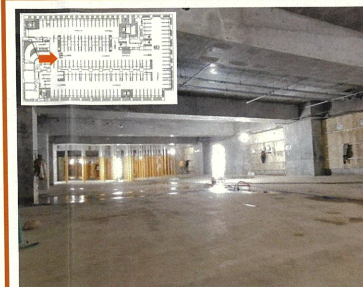
地下 建物内部(駐車場)
