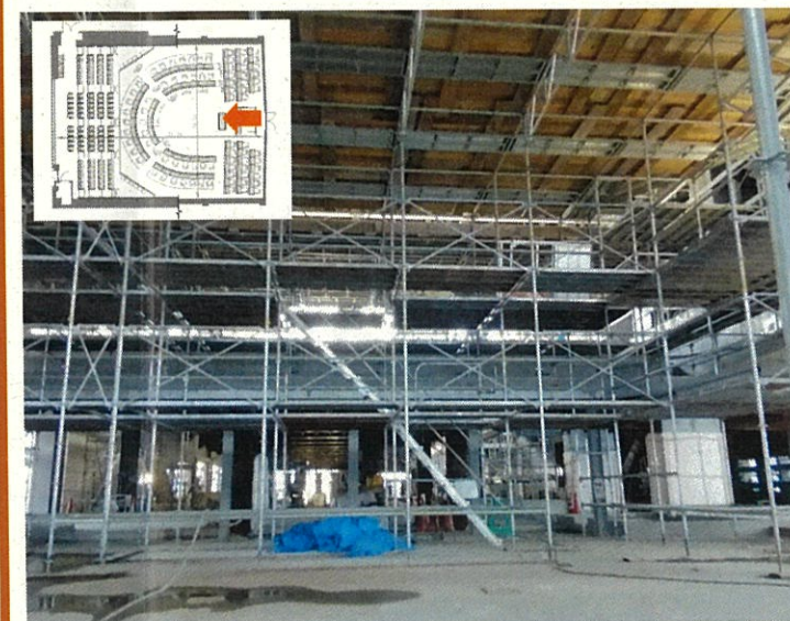
5階 建物内部(議場)
