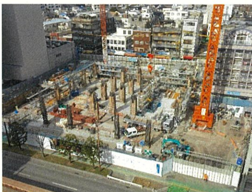
北街区（1階部分建設中）
