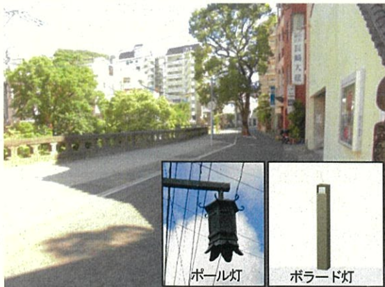
出来大工町桶屋町線（道路照明施設整備） 【大井手橋～馬町交差点間】
