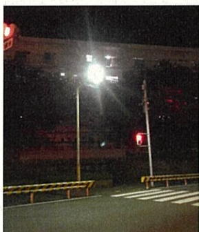
道路照明灯(2,739灯) 〈水銀灯〉
