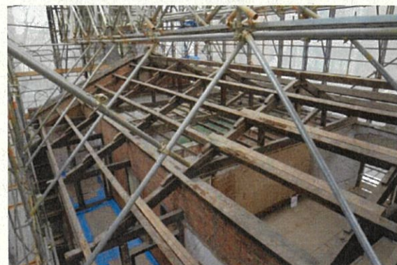
職員住宅煉瓦棟屋根
