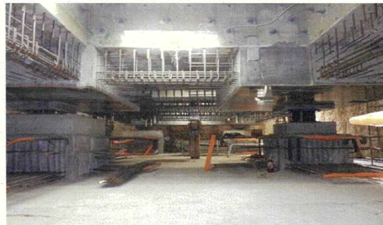
免震装置設置状況
