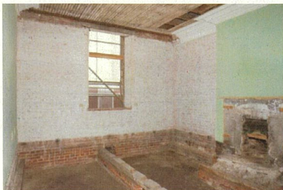
職員住宅煉瓦棟内部 (居間)
