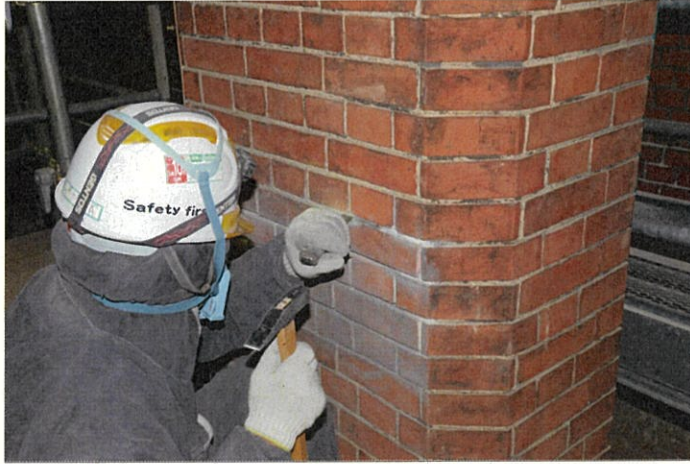
煉瓦接合部目地補修状況
