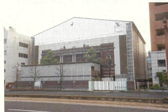
素屋根設置状況
