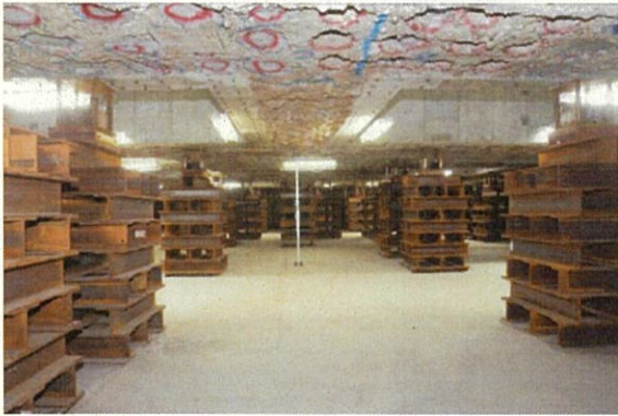
本館地下 (免震装置設置前)
