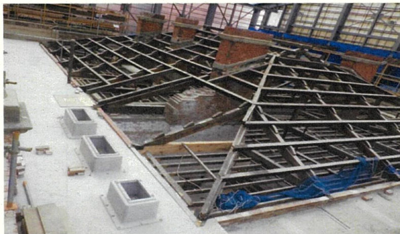
屋根施工状況
