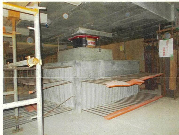
免震装置設置状況
