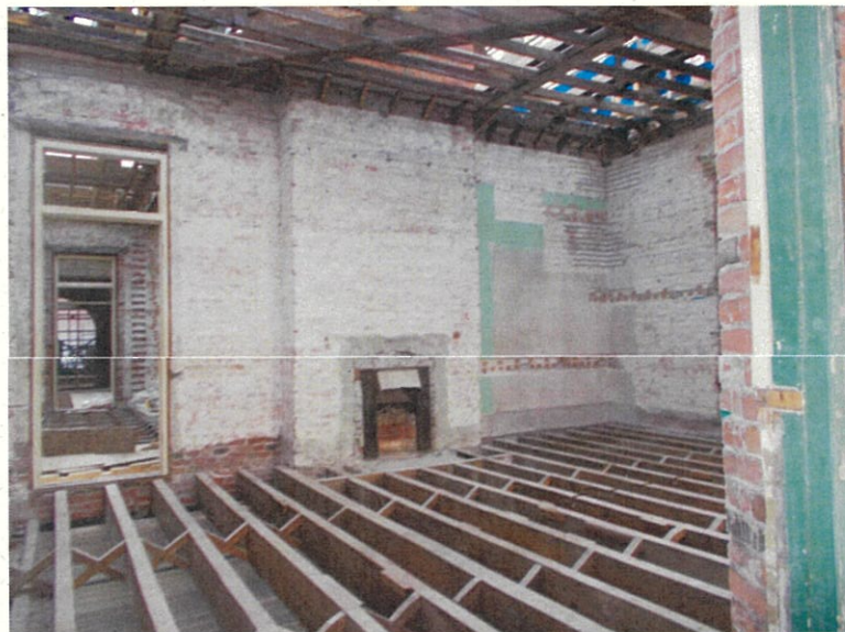
内部施工状況
