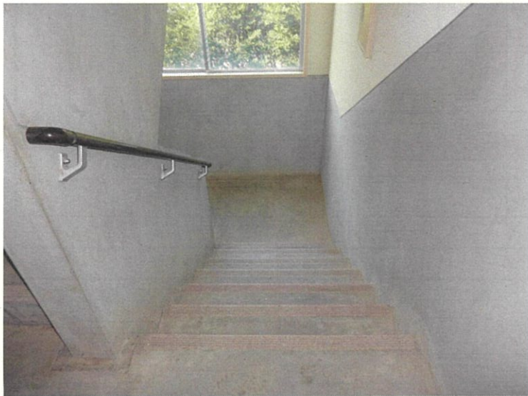
着工前(玄関前より撮影)
