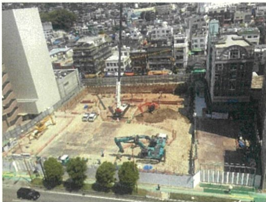
北街区(地下掘削中)
