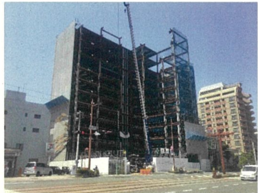
南街区(鉄骨工事中)
