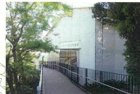
素屋根設置状況写真
