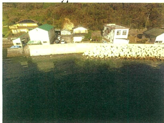
現場写真（令和2年3月撮影）
