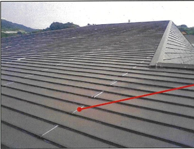
屋根改修（全面）
