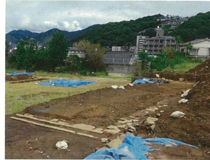
A 建物の礎石及び雨落ち溝 一部移動
