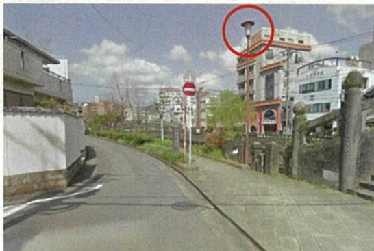
整備前（出来大工町桶屋町線）
