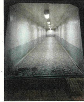
地下歩道灯(58灯) 〈蛍光灯〉
