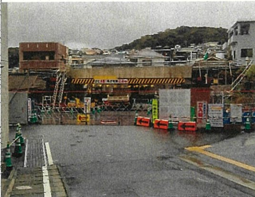
国道側から見た立体交差箇所
