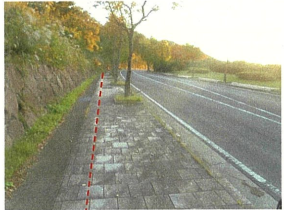
高圧ケーブル
