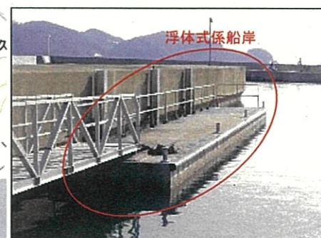
たちばな漁港(網場地区) 移設する浮体式係船岸 (現況)
