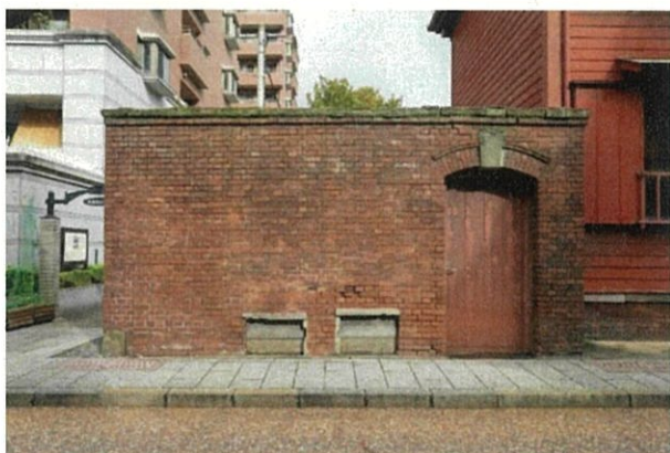
⑤-2 南西隅煉瓦塀
