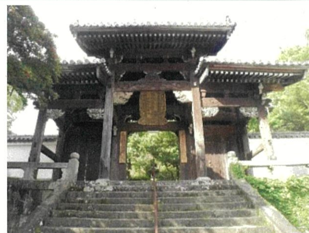
山門（練り堀解体修理）
