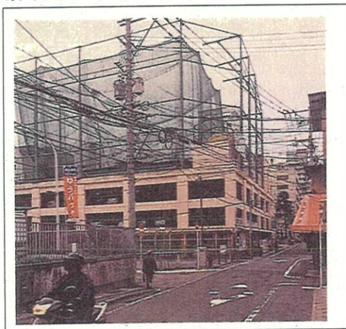
【解体前の様子】
