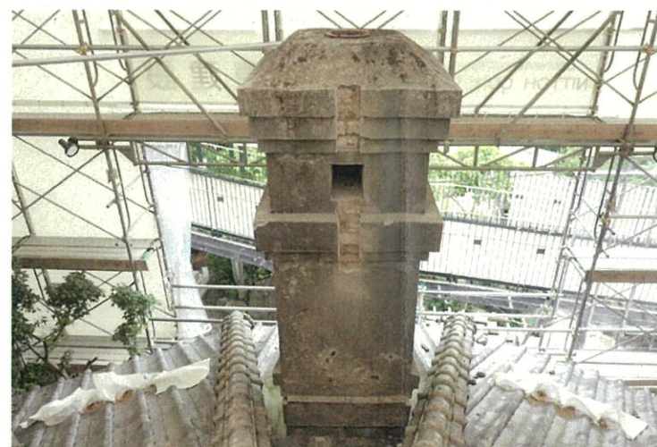
NO. 6 煙突外観
