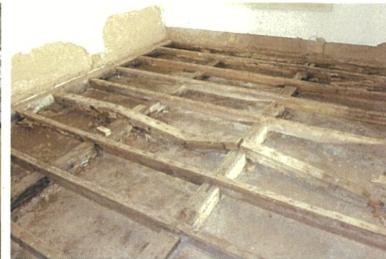
② 使用人室 根太腐朽状況
