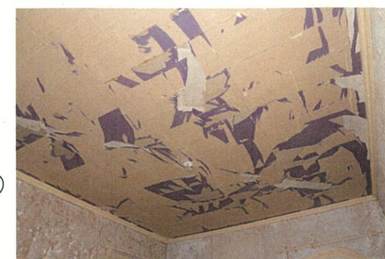
⑧ 天井下張り状況
