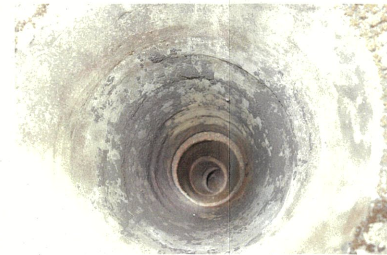
NO. 6 煙道既存状況
