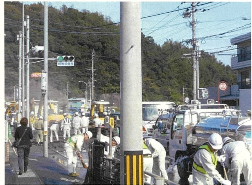
水道管破損事故復旧状況
