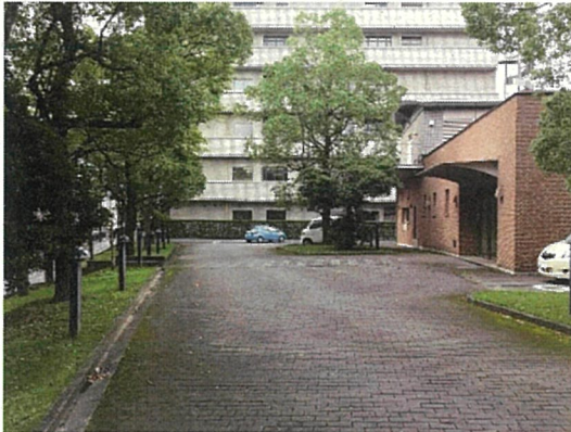
③ 駐車場内部分
