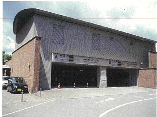
② 茂里町地下駐車場
