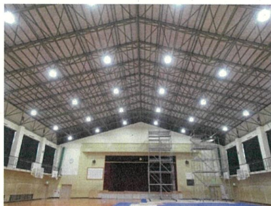
中学校体育館へのLED照明導入
