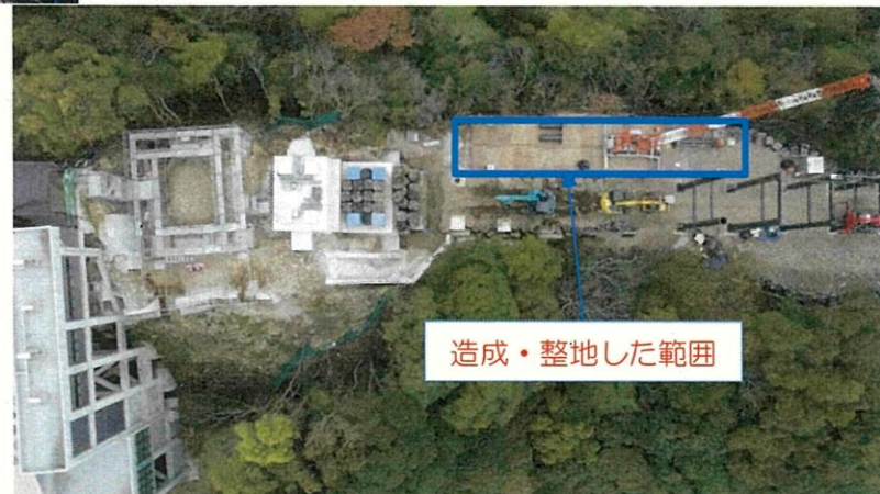
6 造成後上空写真(樹木伐採後)
