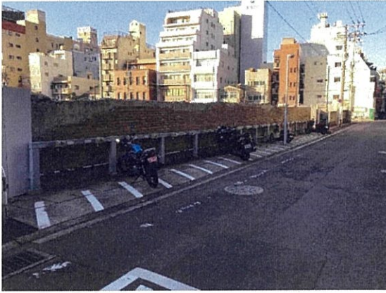
① 全景（長崎署側より）
