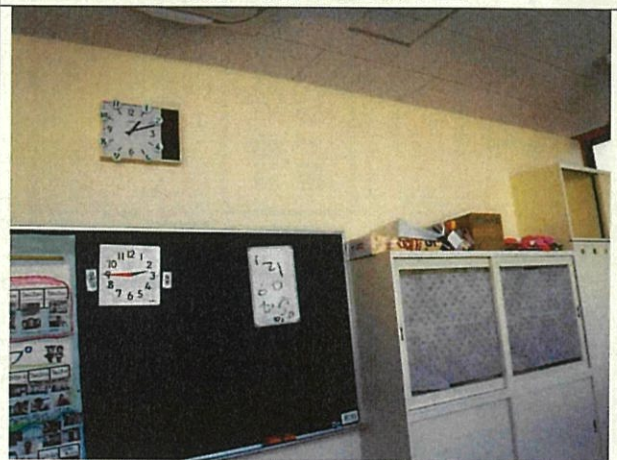
【施工後】間仕切り壁
