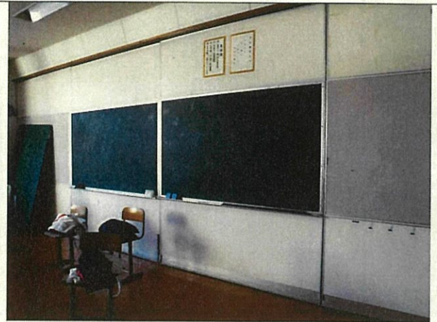
【施工後】スライディングウォール
