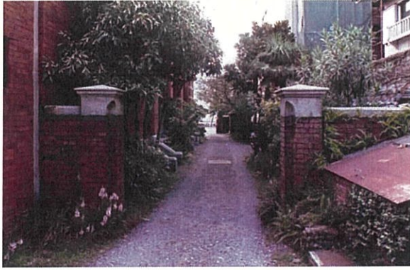
⑤-4 本館東側仕切門
