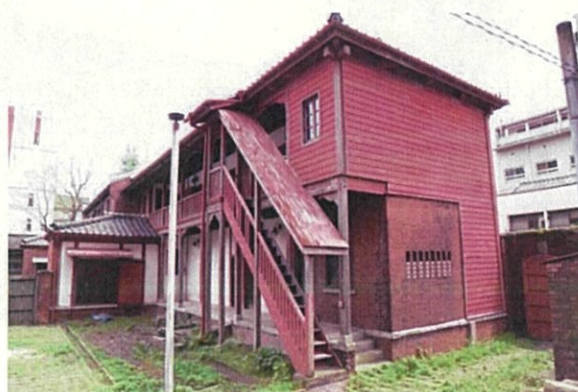
③-2 職員住宅（木造棟）
