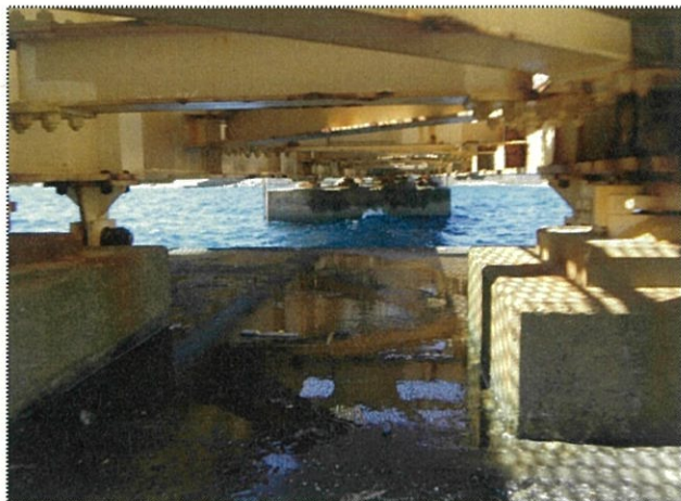
(東側釣台支承) 地点 E
