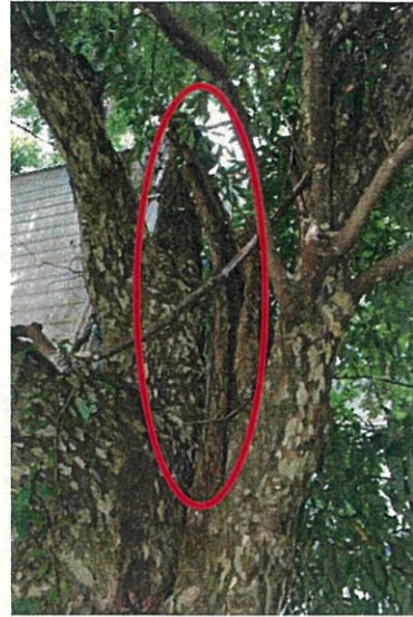
【整備内容】被爆損傷部分の劣化防止処置
