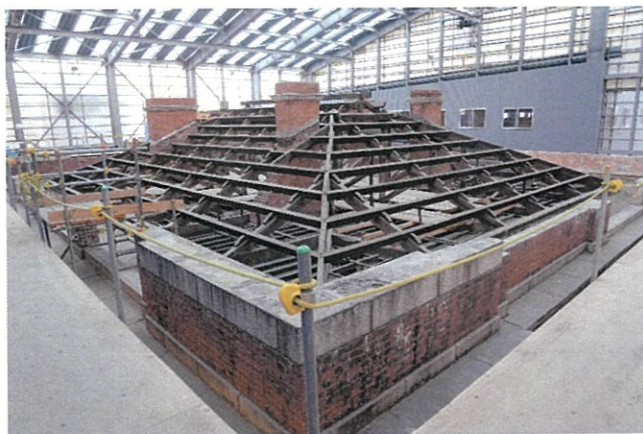
屋根解体完了状況
