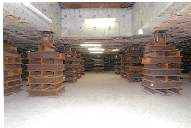
基礎下掘削完了状況
