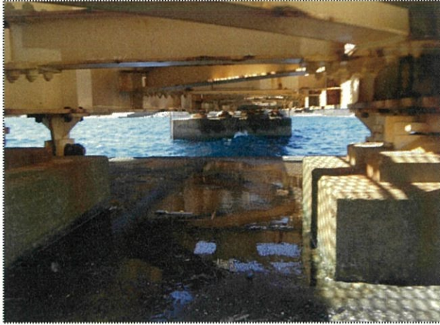
(東側釣台支承) 地点 E
