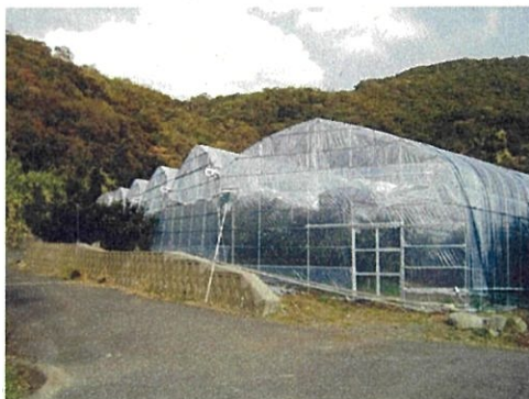
※パイプ径を小さくしアーチパイプスパンを広げ、ハウス建設費を抑える。
