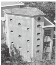
▲長崎原爆遺跡旧城山国民学校校舎
