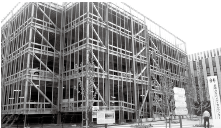
▲現在の駐車場棟
