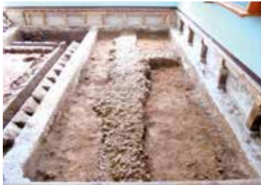
▲小島養生所の建物基礎
