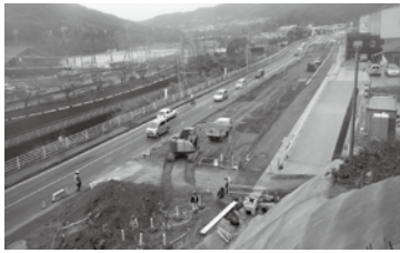
▲拡幅工事を行っている国道499号
