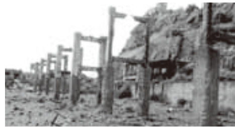
石炭運搬に使用したベルトコンベヤーの支柱(高島炭鉱)
