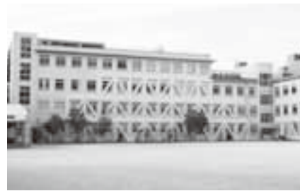
耐震化工事を実施した校舎
