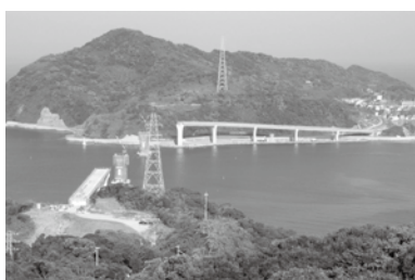
（仮称）伊王島大橋の現在の様子
