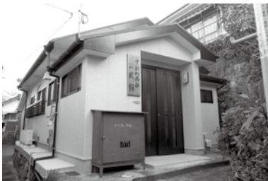
補修工事された自治会集会所
