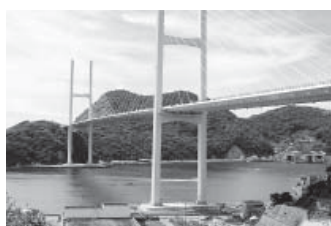
南部地区配水施設整備事業により水道管を添架した女神大橋
