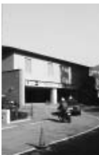
茂里町地下駐車場
