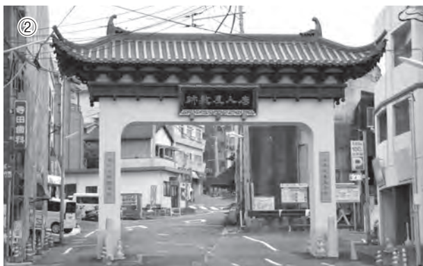
▲ 鎖国時代、出島とともに海外交流の窓口であった唐人屋敷地区の入り口に、シンボルとなる大門が完成
